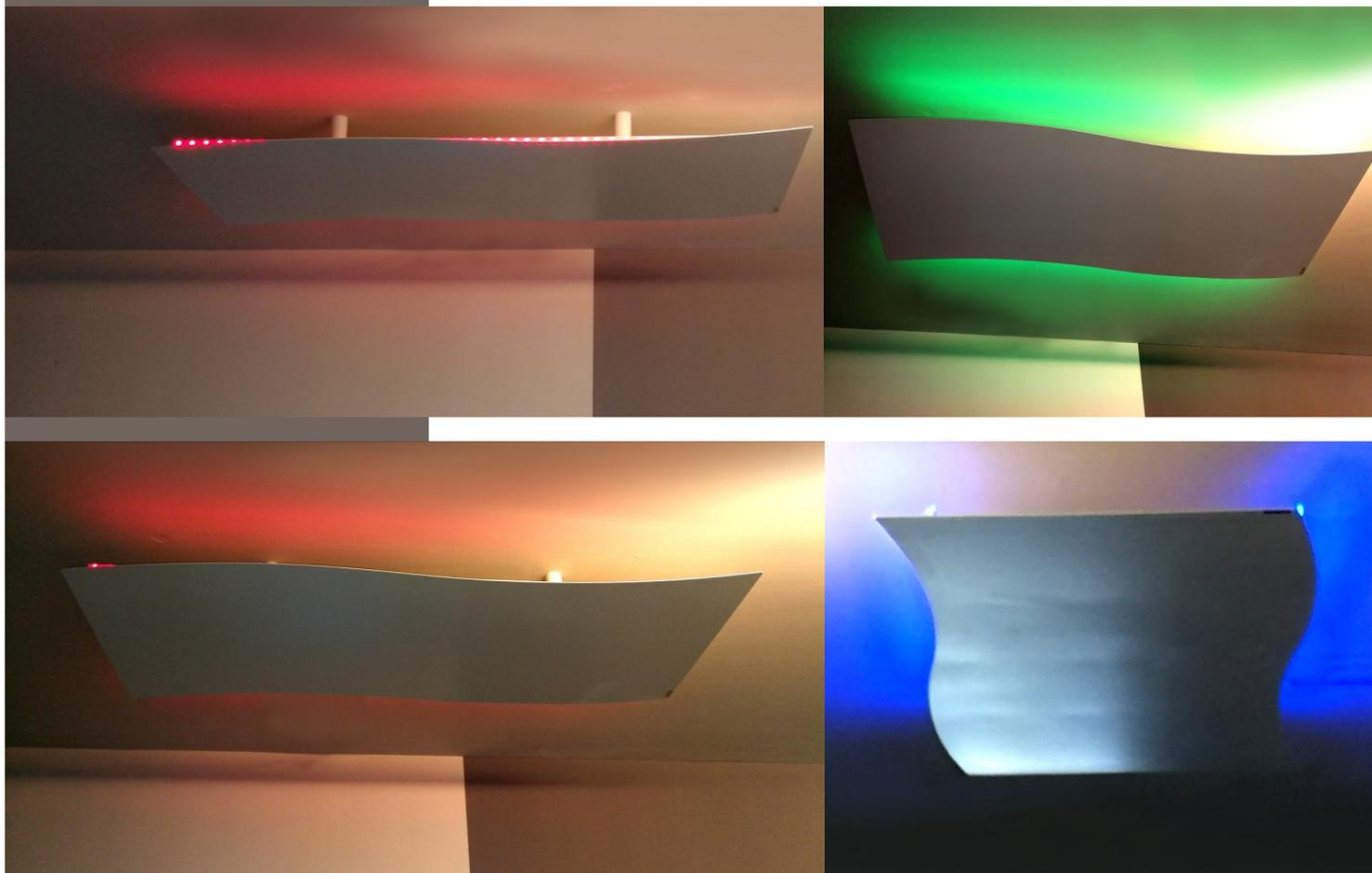
I moduli saranno assicurati a soffitto tramite sistemi di sospensione ad hoc con regolazione di altezza ed eventualmente appoggiati alla struttura del controsoffitto e connessi alle linee idrauliche di mandata e ritorno.
