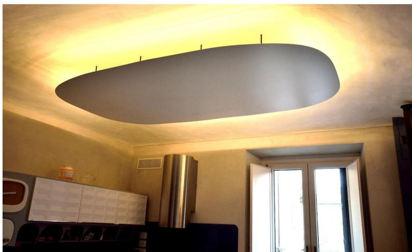
**SOLE** è un sistema di Riscaldamento e Raffrescamento a soffitto per Irraggiamento a bassa Temperatura.
